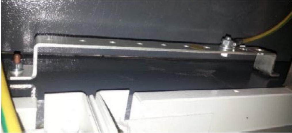
Рис. 3-3 - Шина заземления шкафа.
